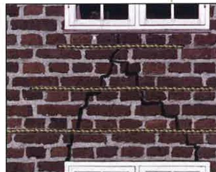
Bild 2: Mauerwerksbewehrung
