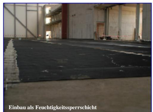
Einbau als Feuchtigkeitsperrschicht
