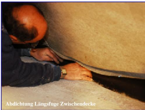
Abdichtung Längsfuge Zwischendecke
