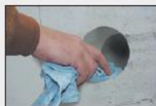
Entstauben der Kernbohrung
