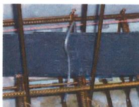
CEMflex VB Verbundblech mit beidseitiger Beschichtung mittig in der Fuge einbauen und fixieren (mit CEMflex Ω - Bügel).
