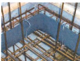
Bei Rundungen + Eckausbildungen das CEMflex Dichtblech einfach in die entsprechende Form biegen.
