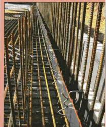
Die Fugenprofile werden in der passenden Höhe überlappt und durch zwei Stoßklammern gesichert. Die Abdichtung des Stoßbereiches erfolgt als Aktivstoß
